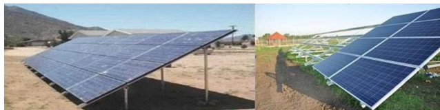
Fig. 41. Sistem fix de montare a panourilor fotovoltaice pe sol
