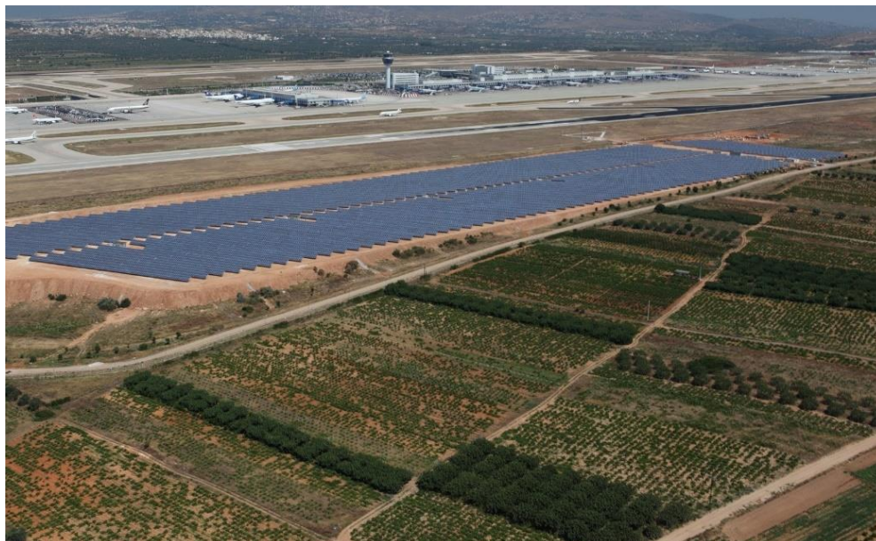
Aeroportul Internațional Atena (Grecia): Capacitate instalată: 8 MW
